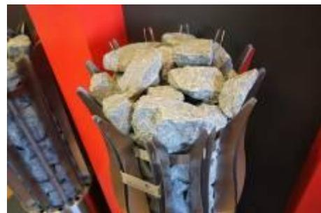
6. Заложите камнями верхнюю часть, пока до конца нагревательных элементов не останется 5-10 сантиметров. Опустите верхнюю пластину на место и заложите печь камнями до конца. Следите, чтобы камней сверху было достаточно. Для верхней части печи лучше выбирать большие камни, чтобы они не могли упасть между профилями.
