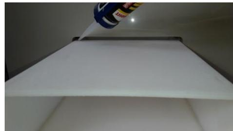
Нанесите герметик по периметру в зазор между коробом и поддоном .
